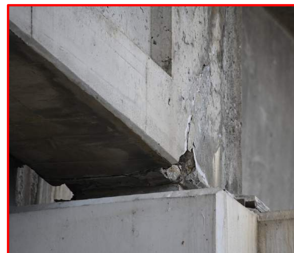
T1桁起点端部
